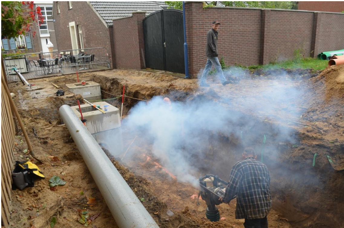
Afbeelding 24: Werkzaamheden in de kerkstraat. Op de achtergrond is de Dorpsstraat zichtbaar.
