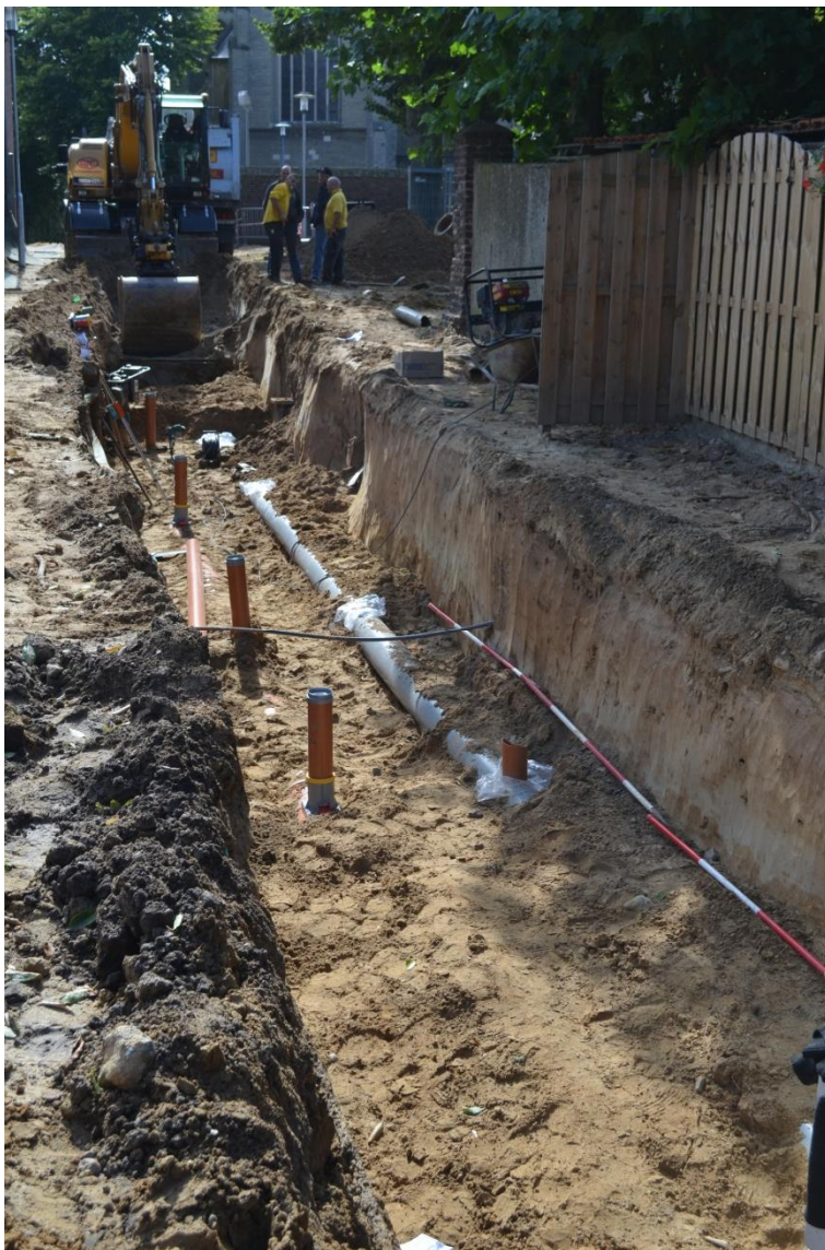
Afbeelding 22: Aanleg riool ter plaatse van de kerkstraat. Op de achtergrond is de kerk zichtbaar.
