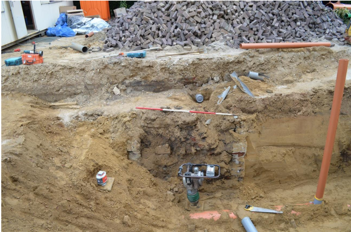
Afbeelding 29: Keldermuur zichtbaar in de noordelijke sleuf aangetroffen bij de verbreding van de sleuf.
