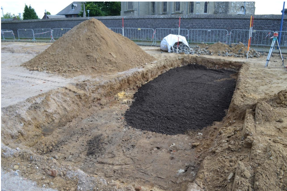
Afbeelding 31: Het boomplantvak wordt opgevuld met compost. Op de achtergrond is de kerk zichtbaar.
